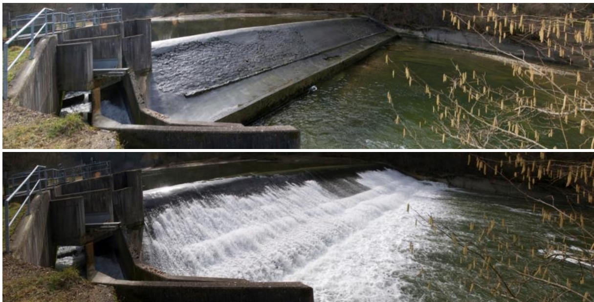
Abb. 2: Kraftwerk Erlenholz bei Sunk und bei Schwall.
