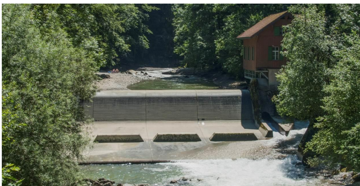
Wasserfassung List, Kraftwerk Kubel der SAK.
